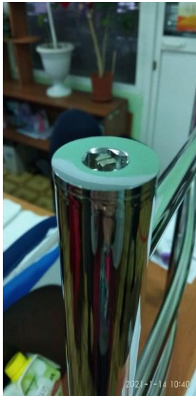
кран маевского (спускник для завоздушивания)
