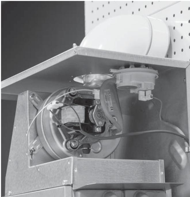
Прессостат предназначен для контроля рабочего состояния системы дымоудаления и отключает котел в нестандартных случаях. Принцип работы следующий: в импульсной трубке во время работы вентилятора создается разрежение, которое втягивает мембрану в прессостате, замыкается контакт, тем самым на плату управления подается сигнал о работоспособности системы дымоудаления. Далее котел запускается в работу. Если замыкания контактов не произошло, котел выдаст ошибку по системе дымоудаления «AF».
