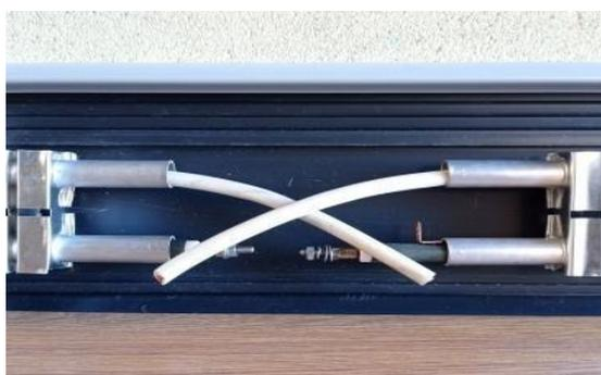
**8-** Снять силиконовую изоляцию с концов кабеля, подготовленных к соединению, на расстоянии 5-10 см от торца. Зачистить концы каждой из трех жил кабеля на 5-10 мм от торца:
