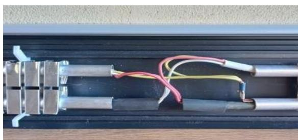
**10-** Место коммутации между двумя теплообменниками закрыть пластмассовым термостойким коробом контактной группы, зафиксировав его на трубках теплообменника:
