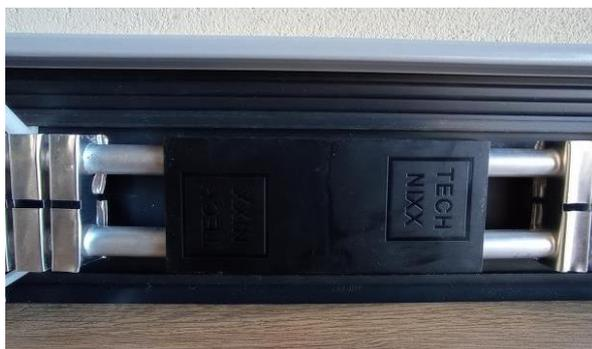
**11-** Установить и зафиксировать закрывающую планку на кронштейнах. Для этого вставить нижний паз закрывающей планки в нижнюю полку кронштейна, затем движением вверх зафиксировать верхний паз закрывающей планки в верхней полке кронштейна
